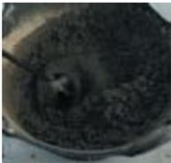
Amasar **weber.tec foc** con 3,5 litros de agua por saco, usando un batidor eléctrico lento, hasta obtener una pasta homogénea y sin grumos.
