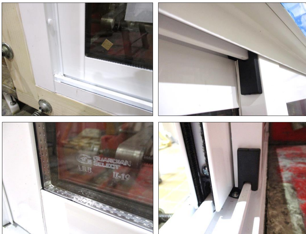
Foto Nº.3. Detalle de perfiles y juntas
