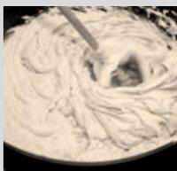
Amasar **webercol flex<sup>3</sup> supergel** con 5,5 -6,5 litros de agua limpia por saco de 25 kg con un batidor eléctrico lento (500 rpm) hasta obtener una masa homogénea y exenta de grumos. Dejar reposar la mezcla unos 2 minutos y realizar un ligero reamasado.
