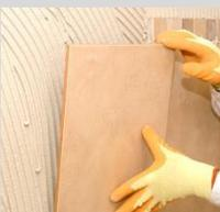
Colocar las baldosas presionándolas hasta conseguir el aplastamiento de los surcos del mortero cola y un buen macizado de la pieza. Comprobar periódicamente la pegajosidad de la pasta levantando la baldosa previamente colocada. Es aconsejable dejar juntas entre piezas colocando cruceitas de 2 mm como mínimo en interiores y 5 mm en exteriores, rellenándolas con morteros de rejuntado de la **gama webercolor**.
