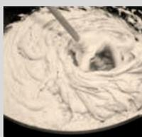
Amasar **webercol flex<sup>2</sup> multigel** con 7,5 -8,5 litros de agua limpia por saco de 25 kg con un batidor eléctrico lento (500 rpm) hasta obtener una masa homogénea y exenta de grumos. Dejar reposar la mezcla unos 2 minutos y realizar un ligero reamasado.
