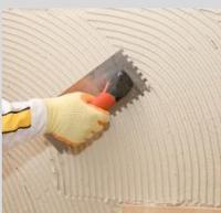
Aplicar con una llana dentada para regularizar el espesor en paños pequeños de máximo 2 m<sup>2</sup>. Respetar el tiempo abierto del adhesivo y en caso que se haya formado una película en la superficie del adhesivo y no existe transferencia, eliminar el material y aplicar de nuevo. Efectuar un doble encolado para piezas de gran formato o elevado peso.
