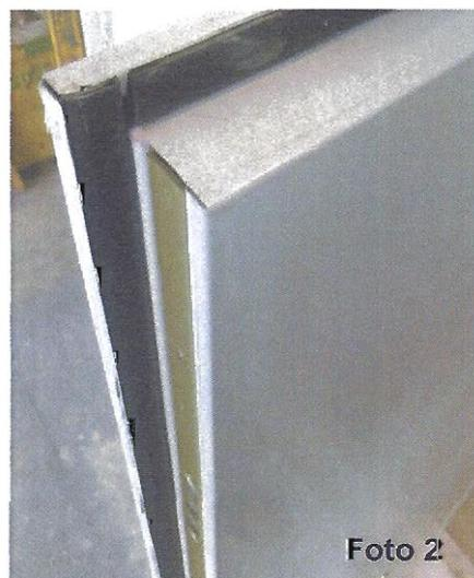
**Fotos 1 y 2:** Detalle junta de estanqueidad en hoja de puerta
