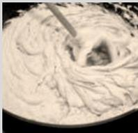
Amasar **adhesivo porcelánico interiores** con 7-9 litros de agua limpia por saco de 25 kg con un batidor eléctrico lento (500 rpm) hasta obtener una masa homogénea y exenta de grumos. Dejar reposar la mezcla unos 2 minutos y realizar un ligero reamasado.
