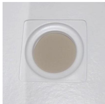
Detalle del orificio del desagüe
