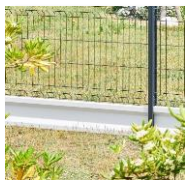
Pose avec plaque de soubassement
