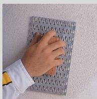
Realizar el acabado (raspado, fratasado, gota...) cuando **webercal hydromur** haya adquirido la consistencia necesaria (de 1 a 6 horas después de su aplicación). **webercal hydromur** puede recubrirse con materiales muy transpirables
