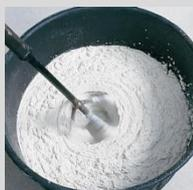
Amasar **webercal hydromur** con 5 - 6 litros de agua limpia, con un batidor eléctrico lento (500 rpm), al menos durante 5 minutos, hasta que la masa esté perfectamente homogeneizada.
