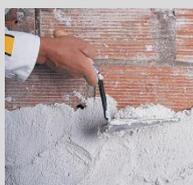
Sobre el soporte húmedo, proyectar **webercal hydromur** con una paleta a modo de salpicado, hasta conseguir un espesor mínimo de 2 cm en cualquier punto. Seguidamente reglear el producto, sin apretarlo, para evitar cerrar el poro. Si necesitamos mayor espesor de producto para conseguir planeidad, aplicaremos **webercal hydromur** en dos capas con un espesor máximo total de 4 cm, colocando una malla entre capas tipo sándwich.
