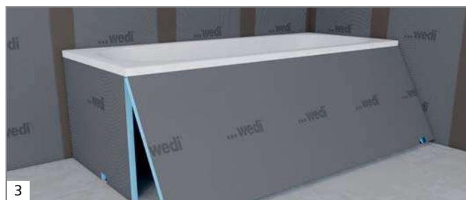
3 Mise en place du tablier de baignoire.
