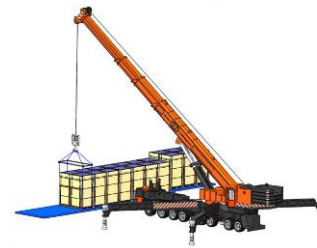
Scarico della confezione verticale con la gru
