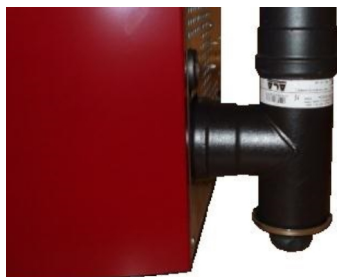
Fig. 78 - Nettoyage du conduit de fumée
