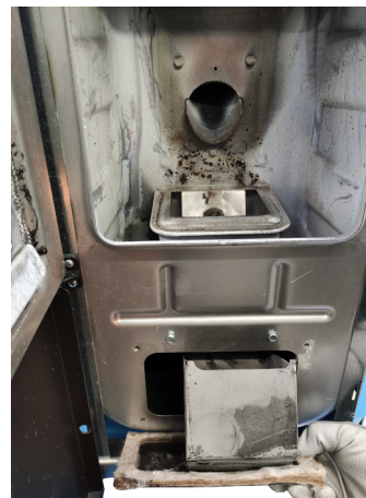
Fig. 83 - Retirer le bouchon d'inspection
