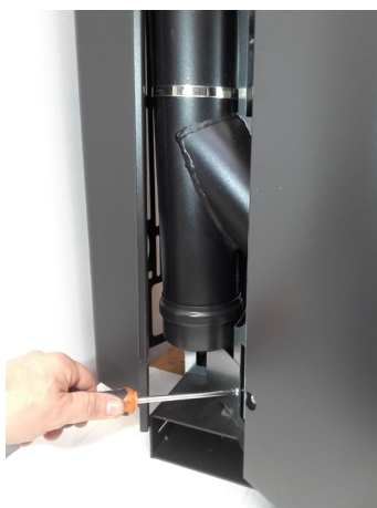
Fig. 80 - Dévisser le dispositif de blocage du bouchon
