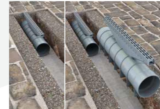
3. Coloque el conjunto en la base y conectelo a la tubería de drenaje.
