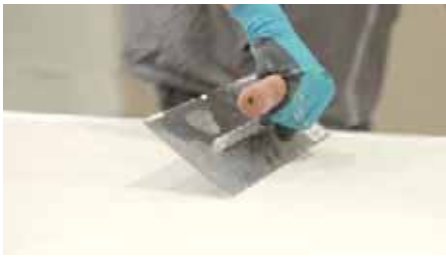
Spatola con denti da 3mm / Spatule dotée de dents de 3 mm
