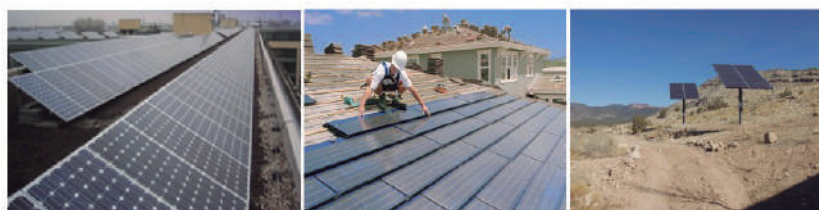
Exemples de montage: Au-dessus du sol, le toit et le mât
