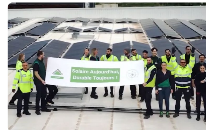
Les panneaux photovoltaïques installés sur le toit du magasin d'Avignon permettent de couvrir 30 % de ses besoins en énergie.
