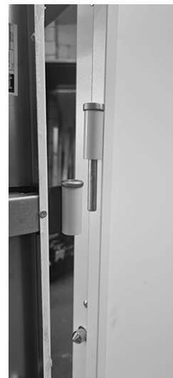
Deculgue la hoja del bastidor. No pierda los rodamientos.
