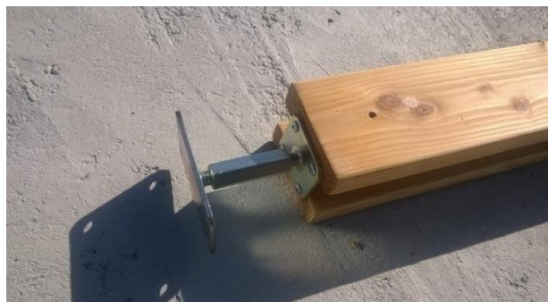
Fixations pied de poteau fixe avec 4 vis 8/80
