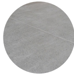
Chape en béton
