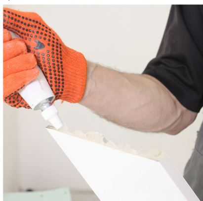
Applicare della colla trasparente sui giunti Apply transparent glue on the joints.
