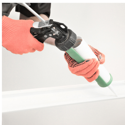
Applicare della colla di tipo MS sulla superficie della battentatura. Apply MS type glue on the fixing overlapping surface.
