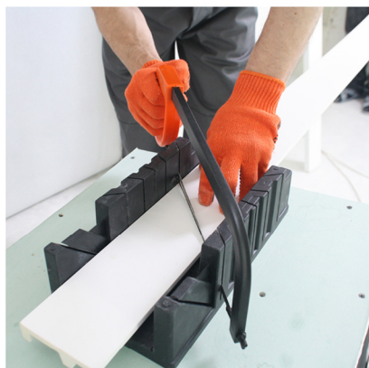
Tagliare la cornice (se necessario) con un seghetto Trim the cornice (if needed) with a saw
