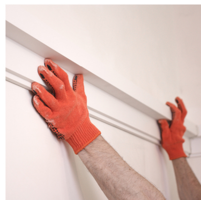
Posizionare con cura il profilo premendolo a muro. Position the profile carefully by pressing it to the wall.
