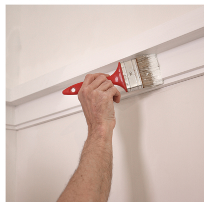
Applicare la pittura finale con un pennello. Apply the finishing coat by brush.
