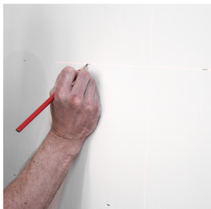
Tracciare una leggera linea sulla parete con l'aiuto di una livella. Trace a line on the wall by following a spirit level.
