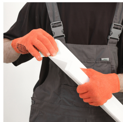
Carteggia i giunti tagliati Sand the cut joints
