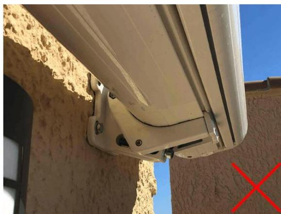
Ce modèle de store est également équipé de deux guides au niveau du coffre, permettant de guider les bras pour les faire entrer dans le coffre. Ces guides ne sont pas des pièces fixées dans la rainure du coffre. Leur position est modifiable (par exemple, les placer en face des articulations des bras lorsqu'ils sont pliés) afin que les bras glissent dessus et ne touchent plus directement le dessous du coffre.
