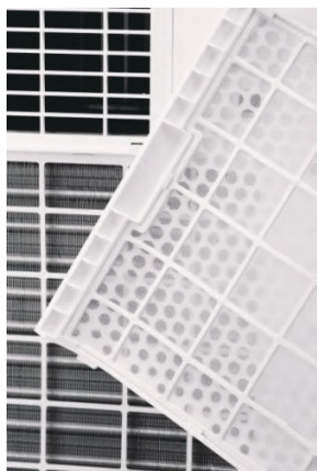
Rys.1 Wyłącz urządzenie i wyjmij dwa filtry powietrza.
