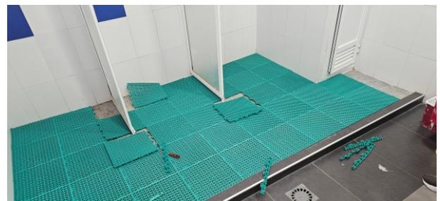
En caso necesario, cortar según necesidad adaptando el corte a la forma deseada.
