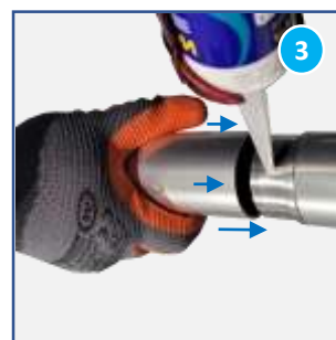
Siliconez également l'autre coté du manchon male et enfillez la main courante
