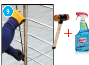
Mettez les cache vis / Astuce: vous pouvez les emboîter plus facilement, à l'aide de produit à carreaux et un marteau plastique (La longueur du cache vis est volontairement plus courte que le montant)
