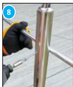
Fixez les lisses à l'aide des vis auto foreuses (O)
