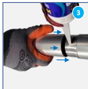
Siliconez également l'autre coté du manchon male et enflez la main courante
