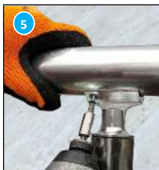
Fixez la main courante à l'aide des vis fournies (P)
