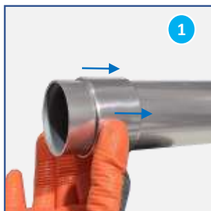
Passer d'abord le manchon femelle sur la main courante avant de commencer
