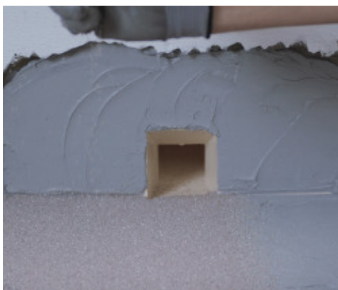
Imperméabilisation de l'écoulement avec Drain Front
