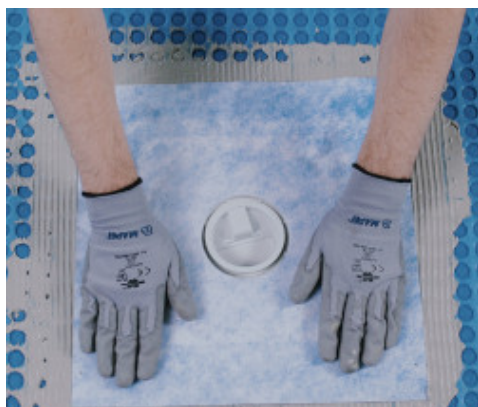
Imperméabilisation de l'écoulement avec Drain Vertical/Drain Lateral
