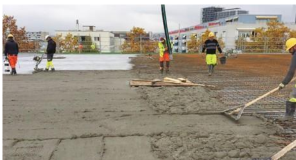
Forme de pente sur toitures et terrasses accessibles (Lausanne Holcim-Lafarge Suisse)
