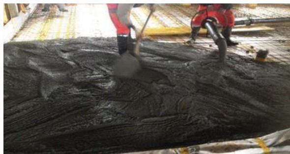
Couche isolante de rattrapage de niveaux Ravaillage conforme DTU 52.1 (Lille France : BPN)
