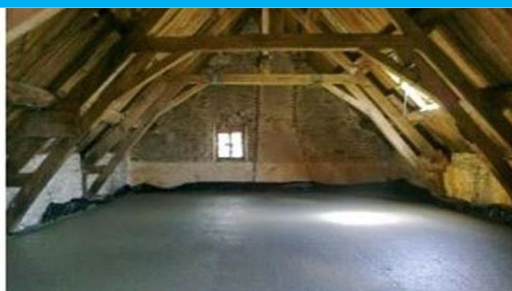
Des milliers de m2 de chape (500 à 1200 Kg/m3) avec Holcim-Lafarge, BGO, Probeton etc. Suisse, Cerf Colas, et BPN France et des artisans ou particuliers en France
