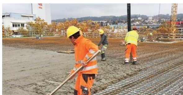
Chapes sur bacs acier autoporteurs ou non (réduction jusqu'à 30% des aciers). (Lausanne Holcim Lafarge Suisse)
