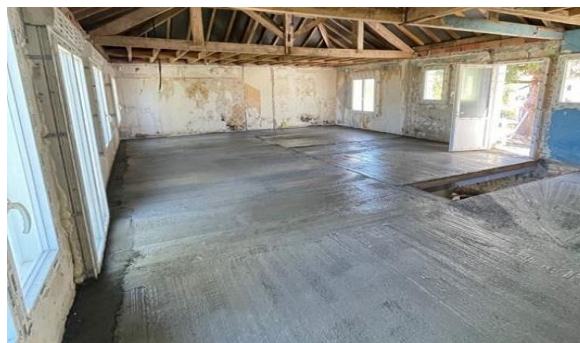
Chape flottantes ou adhérente pour renovation (densité 500 kg/m3) Cerf-Colas BPN France, Holcim-Lafarge Suisse etc.)
