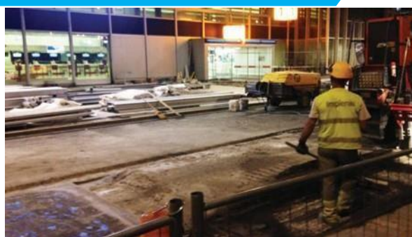
Parkings aéroport de Genève (Holcim Lafarge suisse) massif anti-vibration béton à partir 500 kg/m3 et LC2/3.
