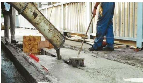
Isolation de Canalisation (Genève Holcim Lafarge Suisse) densité 300 kg/m3
