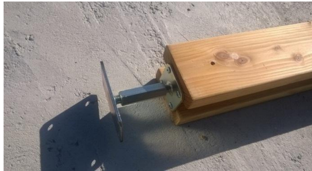
Fixations pied de poteau fixe avec 4 vis 8/80
